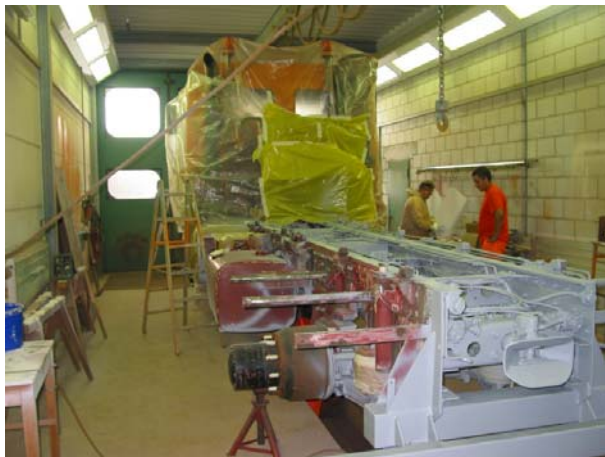
Hilfe beim Lackieren eines LKW
