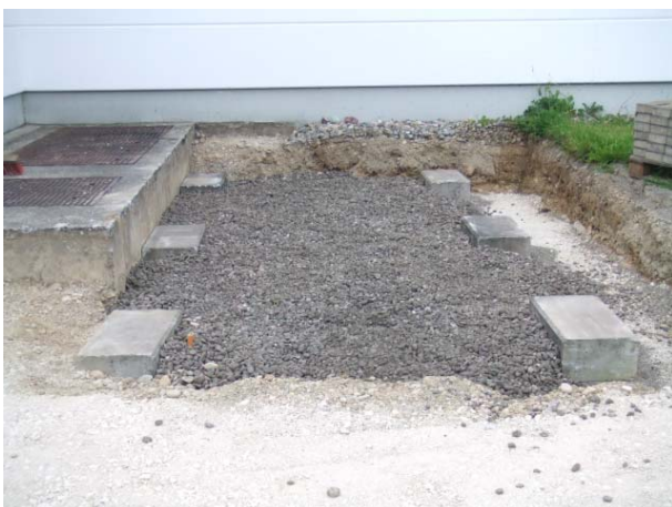
Baugrube und Auflagerpunkte
