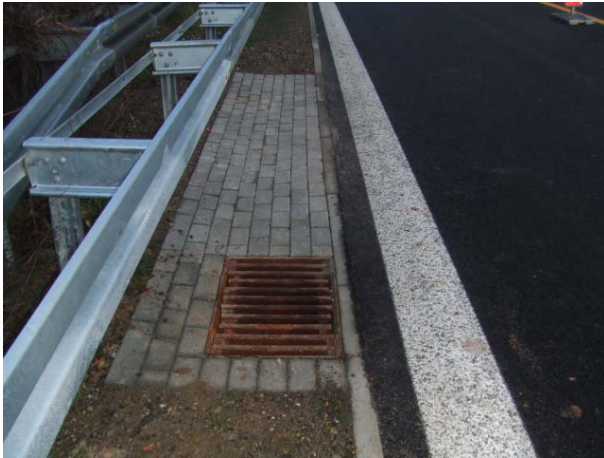
Einlaufschacht neben der Fahrbahn
