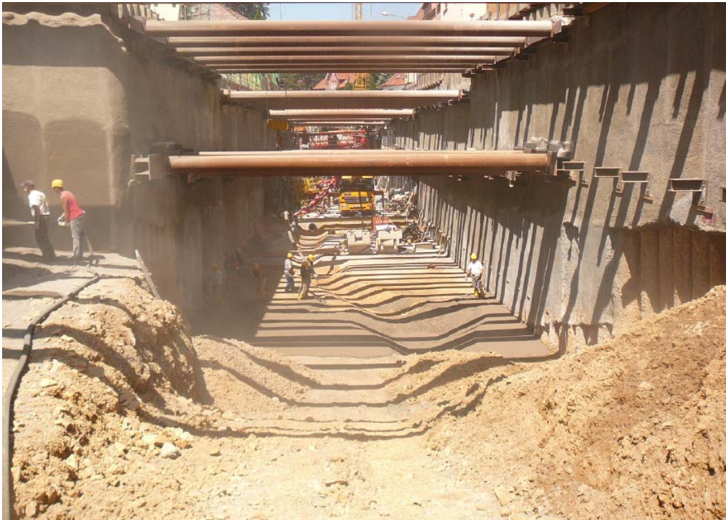
ausgesteifte Baugrube
